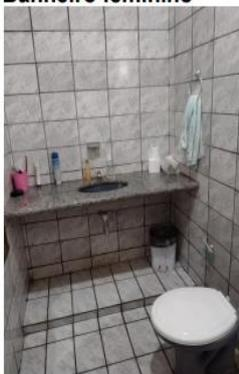
Banheiro sem barra de apoio lateral, sem suportes adequados para sabonetes, papel toalha, etc . Local: 121ZE. Fonte: Doc. SEI 1889017
