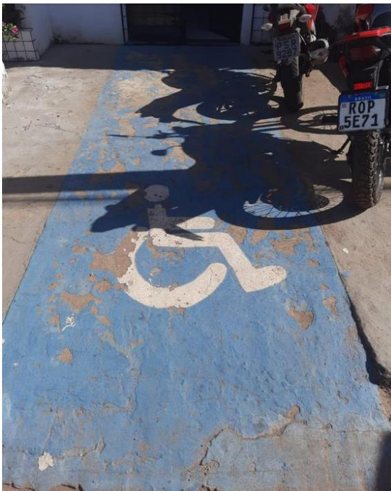
Rampa de acesso com pintura desgastada e sem barra de apoio. Local: 78ZE Doc SEI 1890991.
