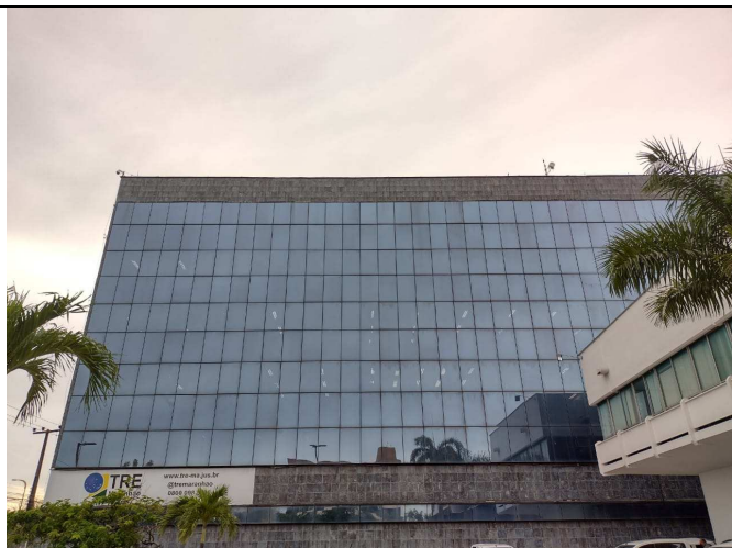
IMAGEM 7: Fachada direita do prédio Anexo.
