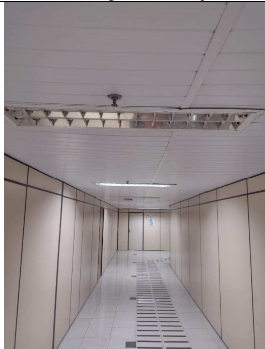
IMAGEM 12: Imagem interna do prédio Anexo.
