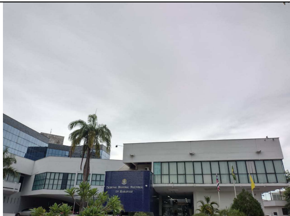
IMAGEM 2: Fachada frontal do prédio Sede.
