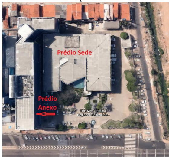
IMAGEM 8: Imagem superior das edificações.
