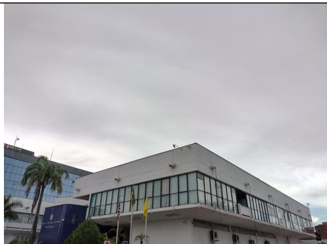
IMAGEM 3: Fachada frontal e lateral direita do prédio Sede.
