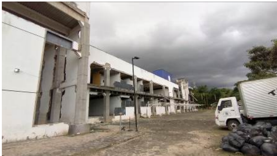
Foto 03 – Fachada principal (área de Oficinas e Administrativa)
