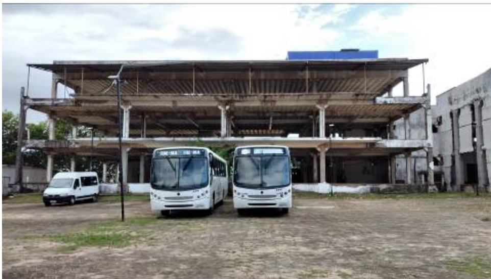
Foto 7 – Fachada dos fundos da área administrativa com paredes a construir e pilares e vigas a executar estucamento e lixamento
