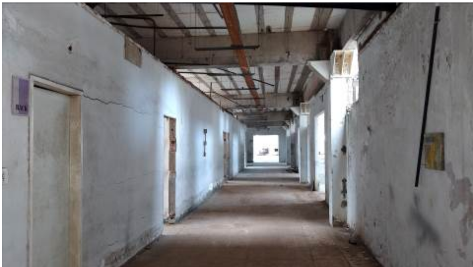
Foto 5 – Corredor interno com paredes de alvenaria e piso a demolir
