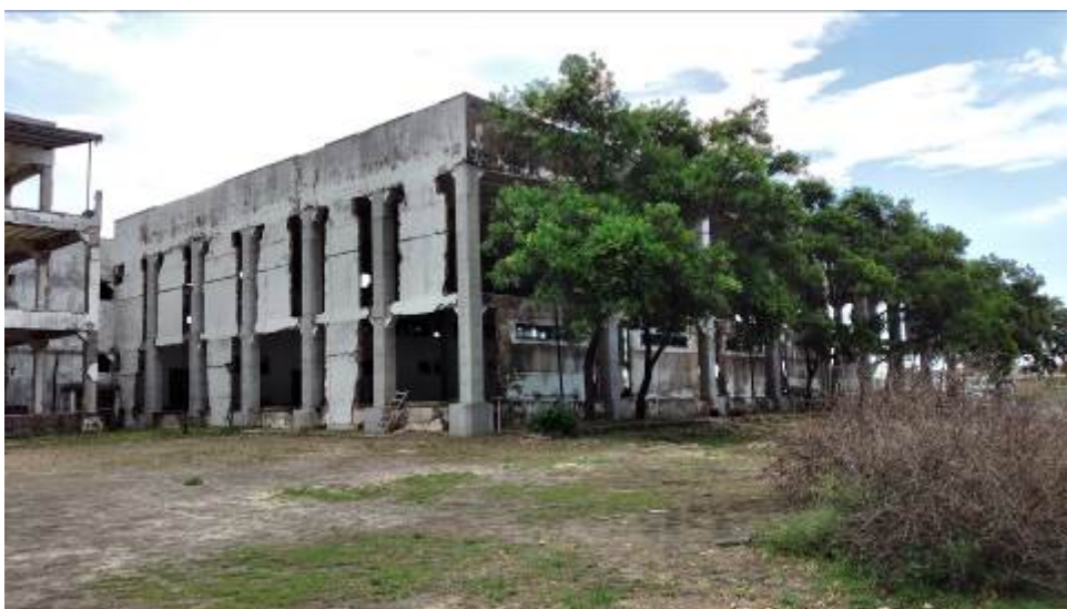
Foto 6 – Vista da fachada lateral e fundo do Depósito de urnas com paredes a demolir
