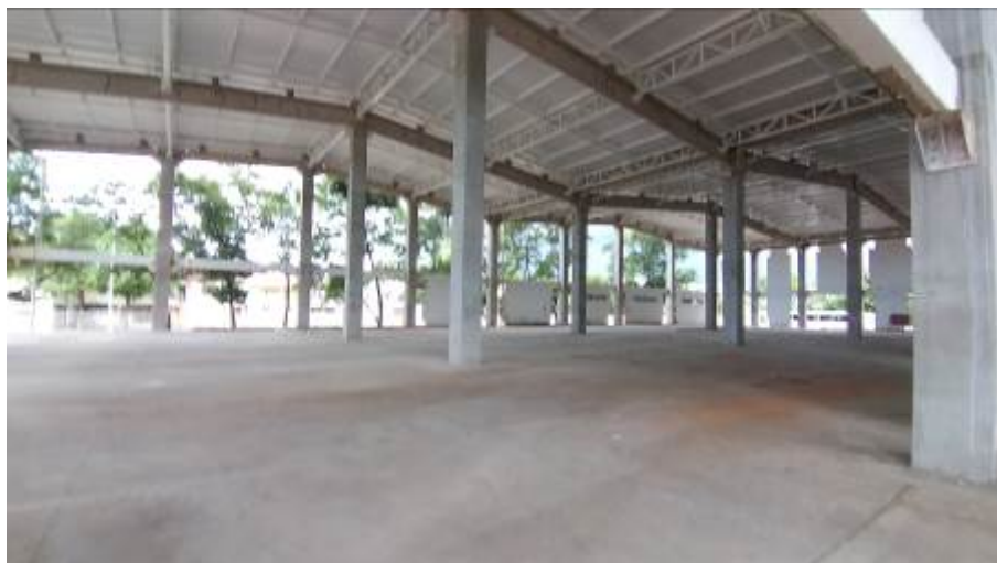
Foto 4 – Área do Depósito de urnas já com a nova cobertura metálica que será replicada na área das Docas
