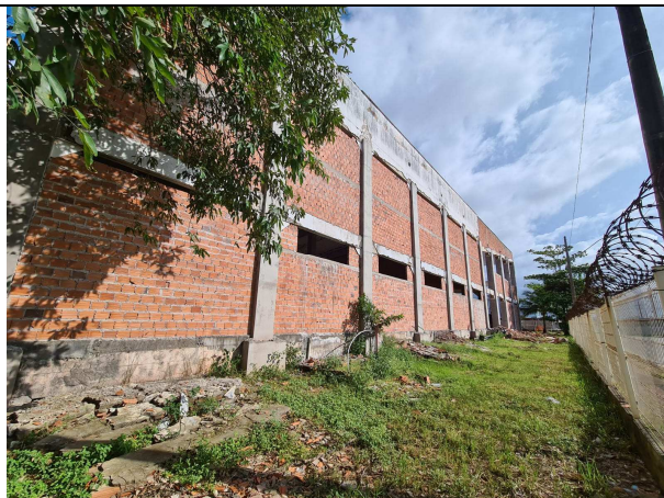
IMAGEM 4: Fachada lateral Docas e Depósito de Urnas
