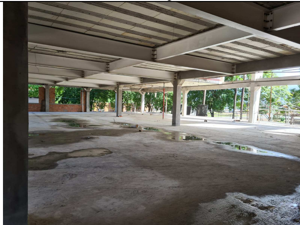
IMAGEM 6: Área da laje do térreo da Administração
