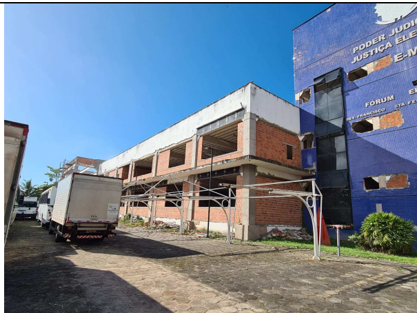
IMAGEM 2: Fachada frontal Oficinas.
