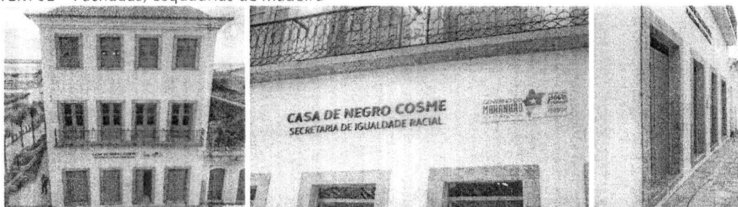
Serviços: Detalhe da fachada com as esquadrias em madeira e vidro, gradil e restauro de pedra lioz.
