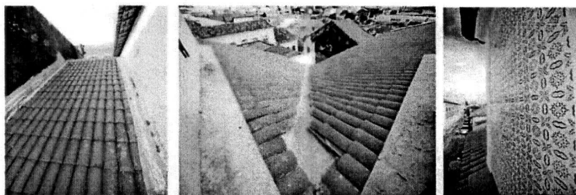
Recuperação de telhado em telhas cerâmicas, incluindo substituição, calçamento com manta em alumínio.
