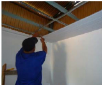
Colocação dos perfis de PVC para forro
