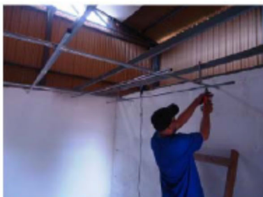
Montagem da estrutura de sustentação dos perfis de PVC para forros, composta por perfis e pendurais metálicos
