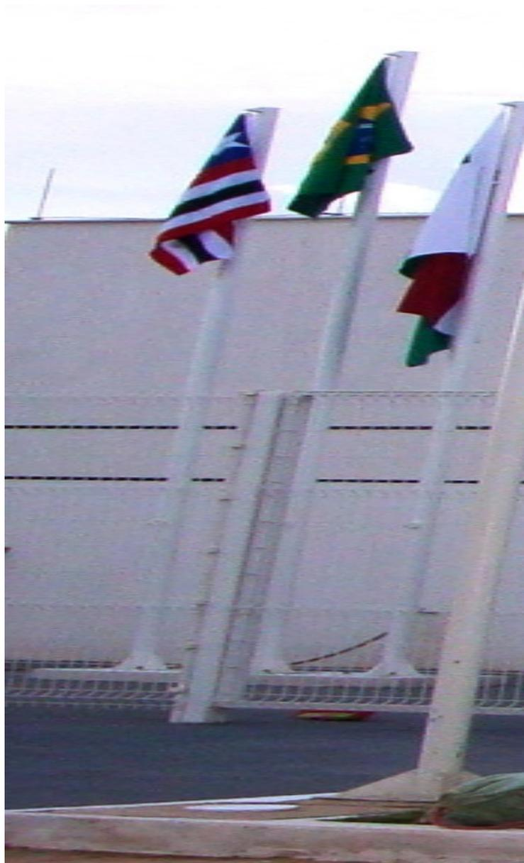
Conjunto de 3(três) mastros – (1 com 6,0m e 2 com 5,5m de comprimento) com roldanas, em tubo galvanizado de 3" e espessura de 2,5mm, fixado em base de chapa de 3/8 med.30 cm x 30 cm, com 4(quatro) parafusos.
