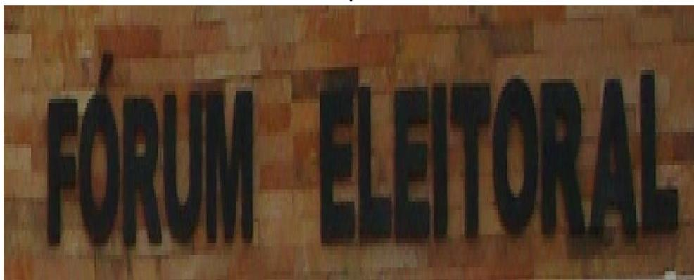
Letra confeccionada em chapa galvanizada, com fixadores, preparada com zarcão e pintada de preto fosco automotivo para fixação em fachada de prédio
