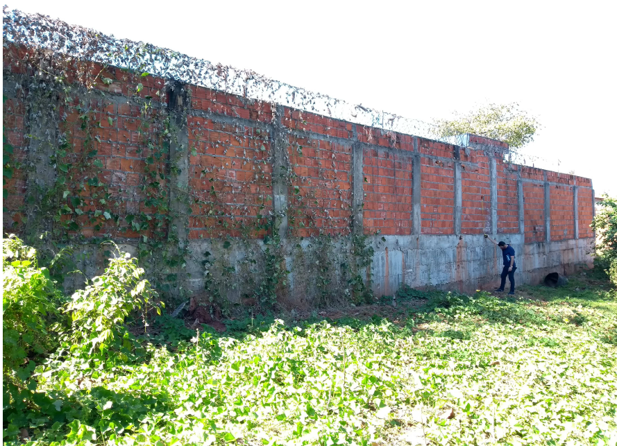
VISTA DO FUNDO DO TERRENO – CONTENÇÃO DO ATERRO
