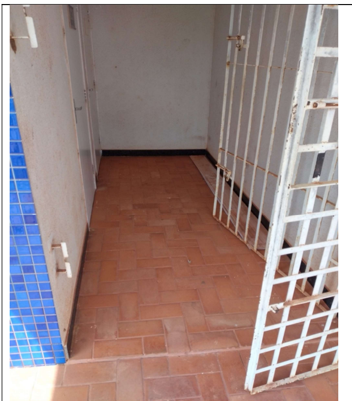
Hall dos banheiros externos. Local deverá ser substituído o forro PVC por forro de Gesso e piso terracota por piso de placas cerâmicas.
