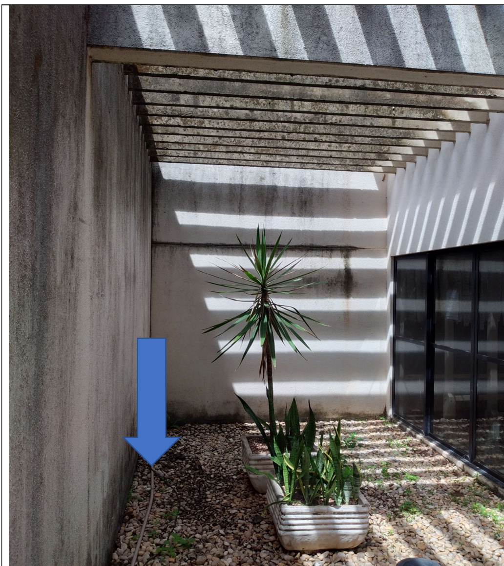
Tubulação de alimentação da cisterna que deverá ser embutido.
