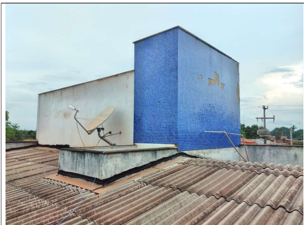
Revestimento da torre da caixa d'água – Pode ser observado o deslocamento do revestimento.
