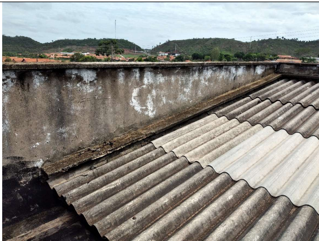
Rufo de concreto danificado. Necessita de substituição.
