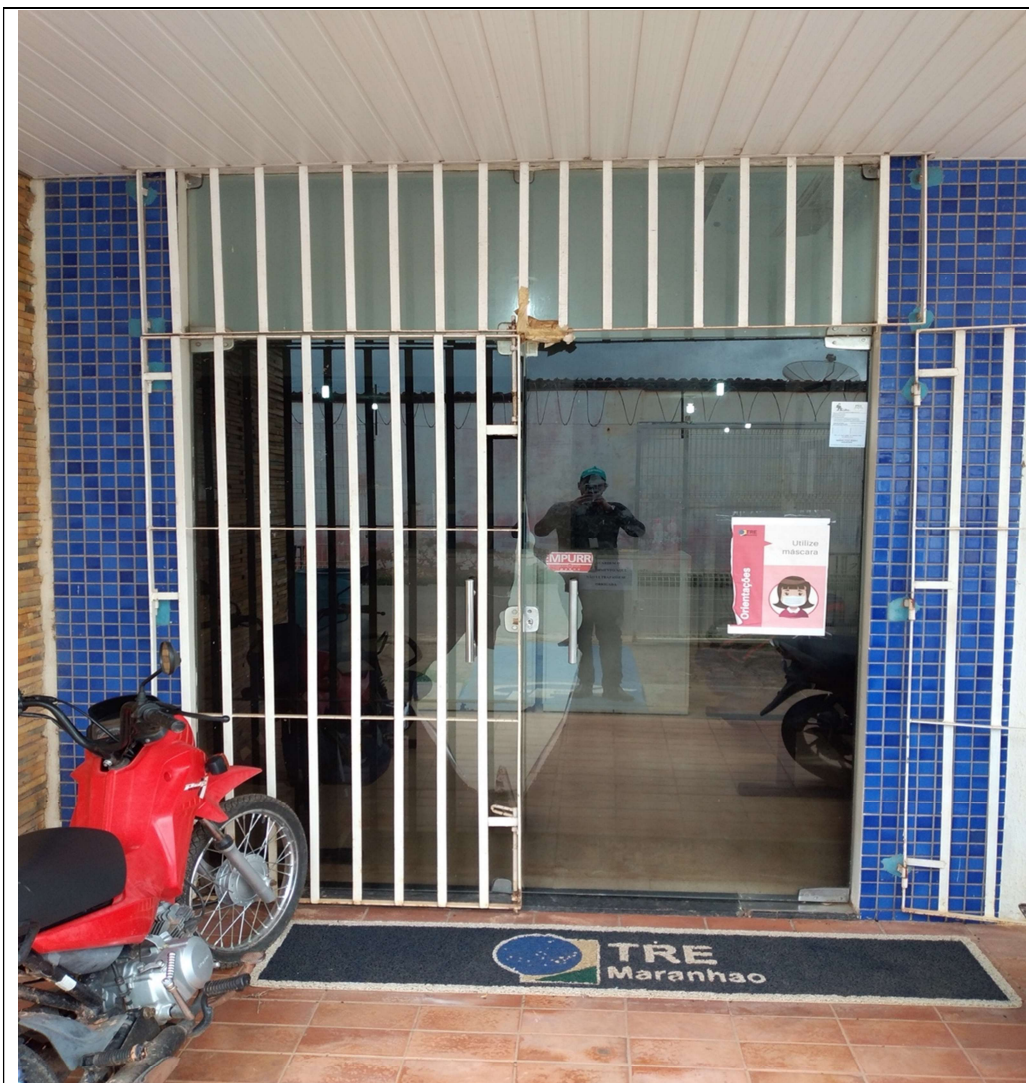
Porta de vidro de acesso principal – substituir puxadores.
