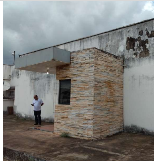
Parede externa da guarita revestida com pedras.
