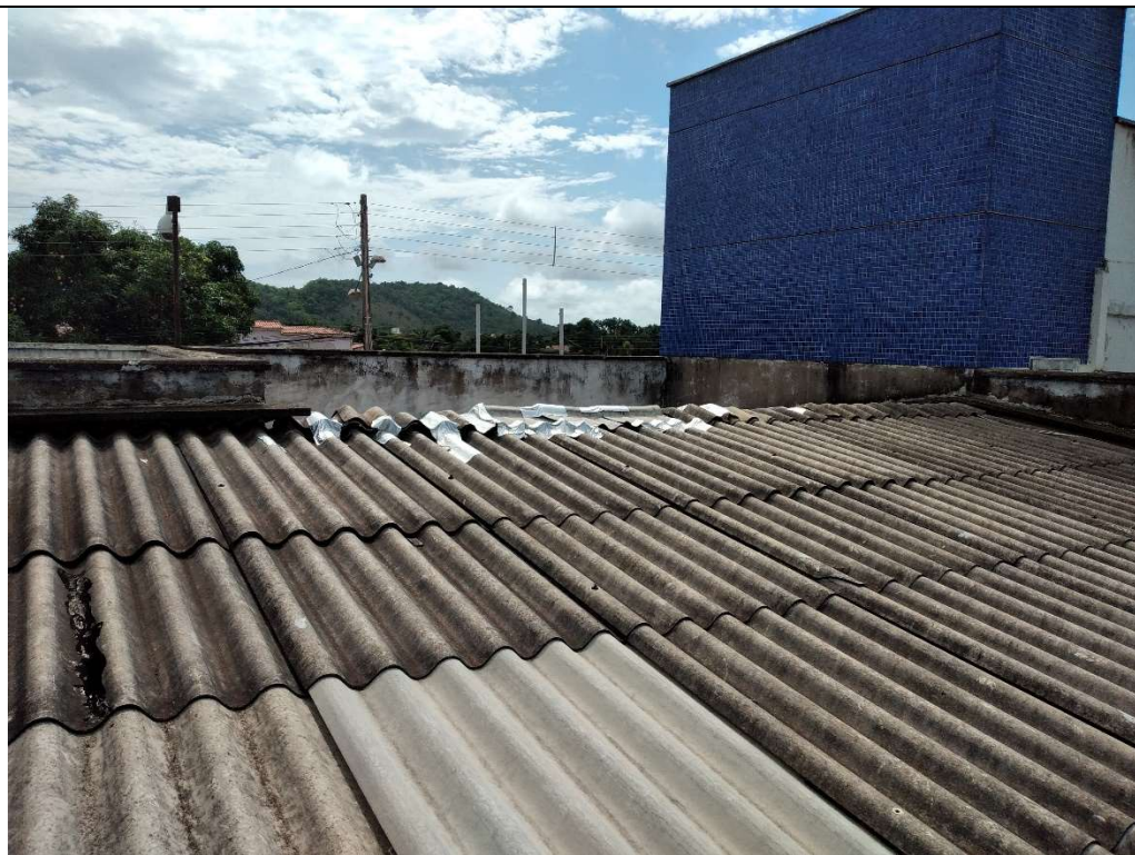
Cumeeira danificada. Necessita substituição.
