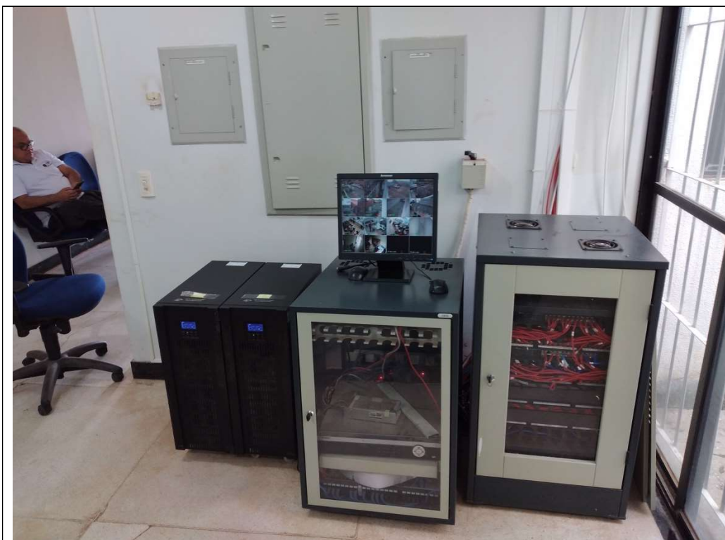
Localização dos quadros Geral, Força e Estabilizado.
