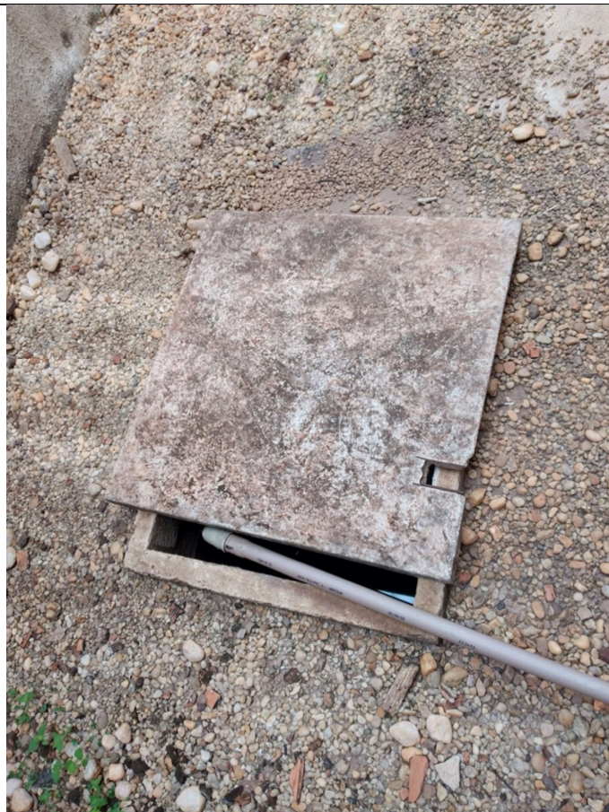
Tampa de concreto do reservatório.
