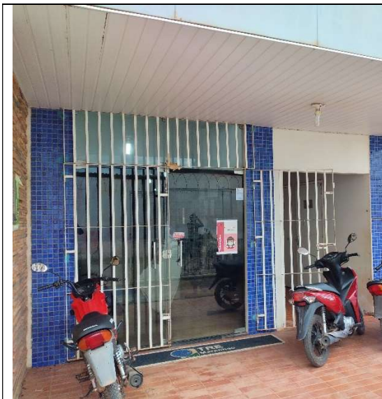
Forro PVC de régua da entrada principal da edificação.
