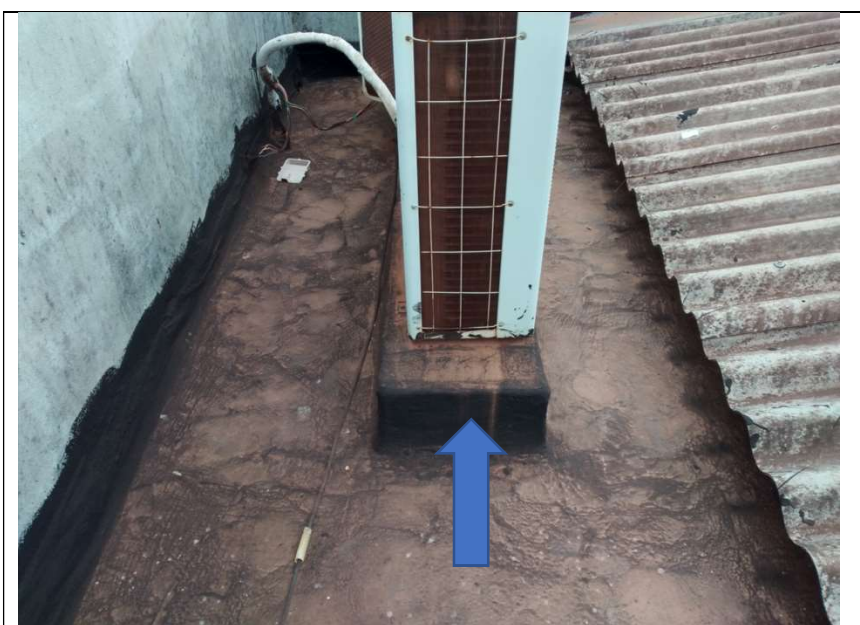
Nicho de alvenaria das condensadoras – Demolição.
