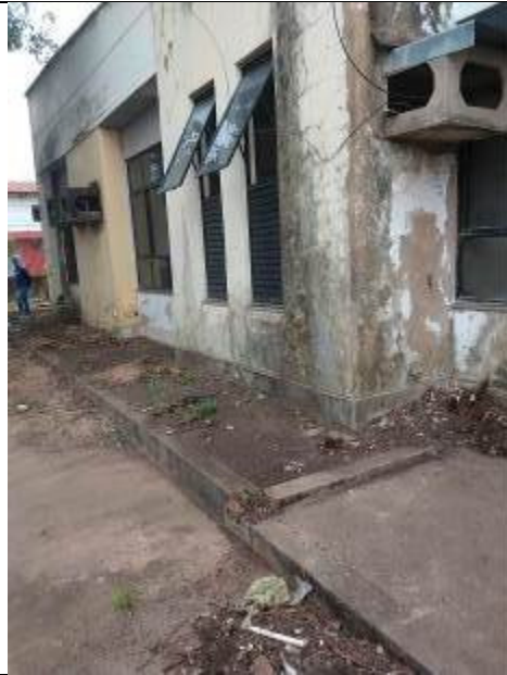
Fachada lateral direita
