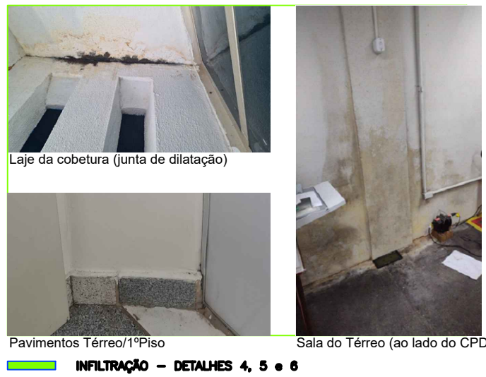
INFILTRAÇÃO - DETALHES 4, 5 e 6
