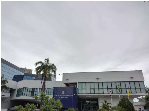
IMAGEM 1: Fachadas dos prédios Sede e Anexo.
