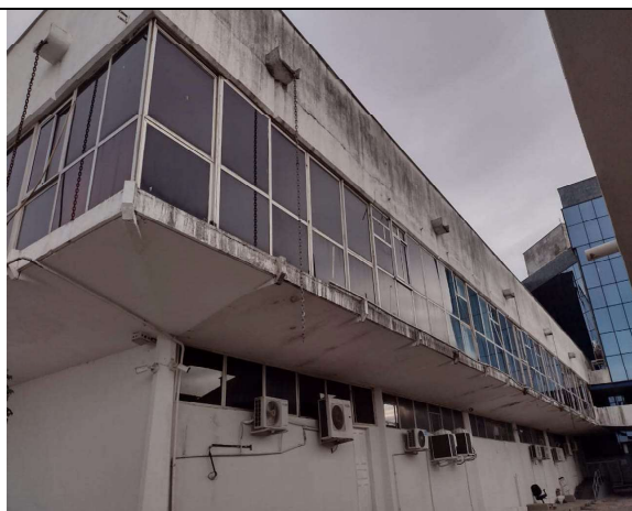
IMAGEM 3: Fachada fundo do prédio Sede.
