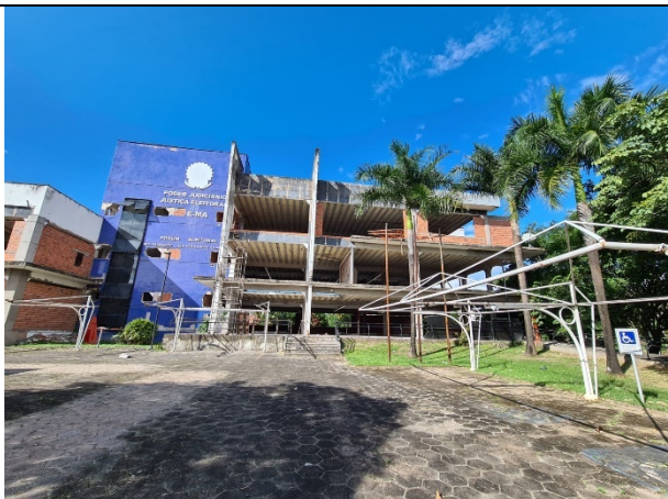
IMAGEM 1: Fachada frontal da Administração.
