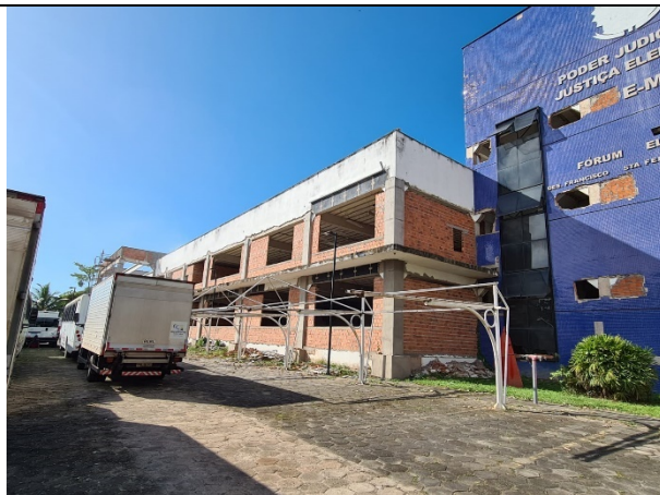
IMAGEM 2: Fachada frontal Oficinas.
