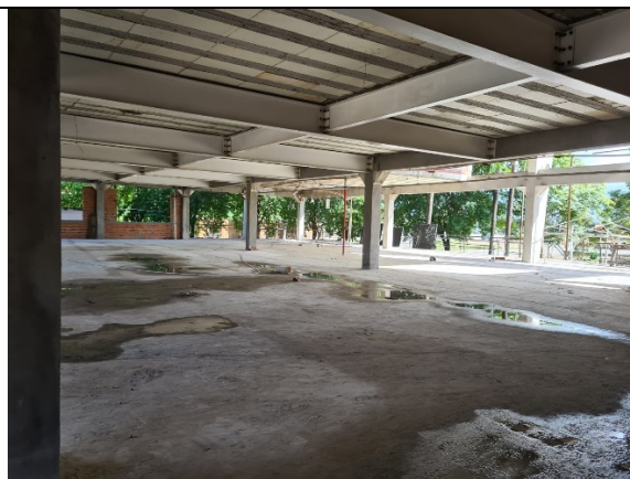
IMAGEM 6: Área da laje do térreo da administração
